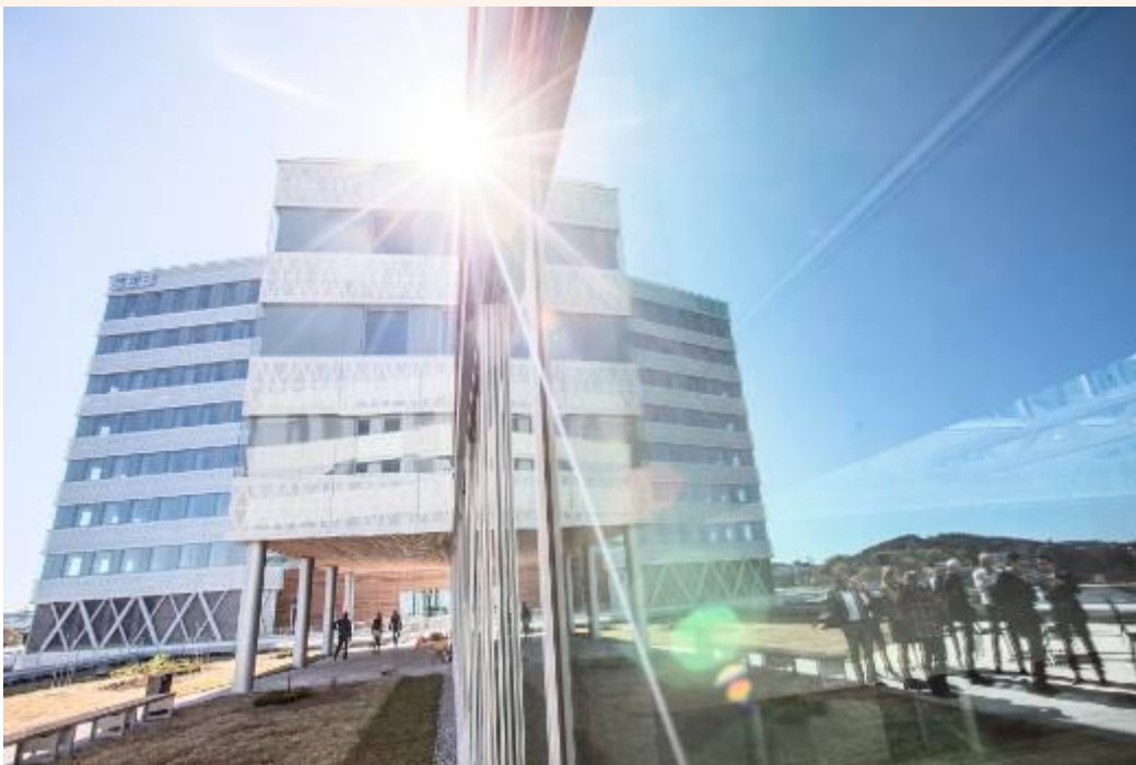
Takterassen kommer bli en naturlig mötesplats för de anställda. Foto: Adam Wrafter Bild 10 av 11
